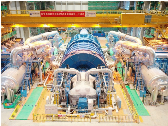
自主设计制造的首台“华龙一号”海南昌江核电二期工程3号汽轮发电机组完成非核冲转工作
