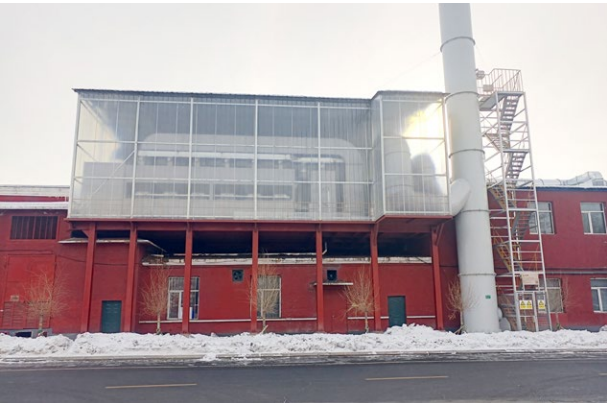
佳电股份喷漆净化设备
