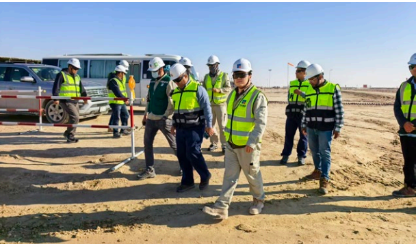
国际公司组织项目现场安全检查
